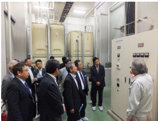
釧路東水冷凍(株)窒素氷自動製氷工場内部
